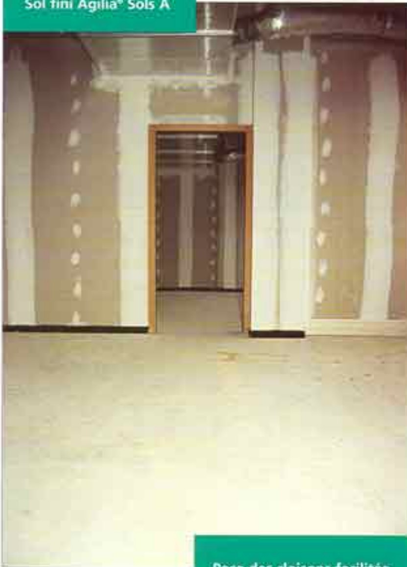
Pose des cloisons facilitée
